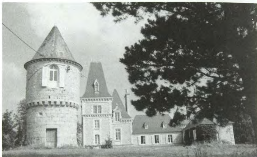
28. Façade sud du château de Crec'h Bleiz et, au premier plan, l'ancien moulin transformé en chapelle. La fenêtre est celle de la chapelle. On y accède de l'autre côté. (Photo Giselle Huot, 29-08-1991)
